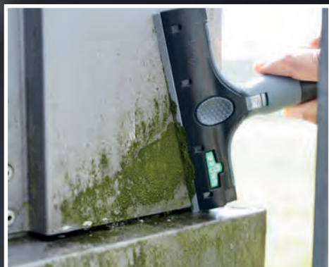
Superficies pintadas y recubiertas
